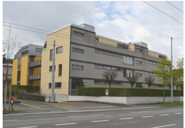
Der Bau an der Wehntalerstrasse 555/557. Foto: Pia Meier
