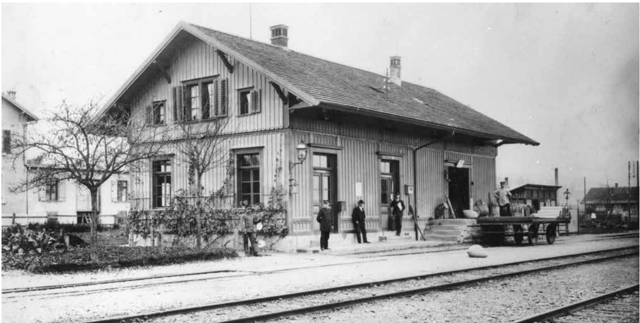
Der Bahnhof Affoltern vor 1909: Das ursprünglich eingeschossige Holzgebäude wurde schon 1880 aufgestockt und im Jahr 1909 linksseitig mit einem Wartsaal ergänzt.
