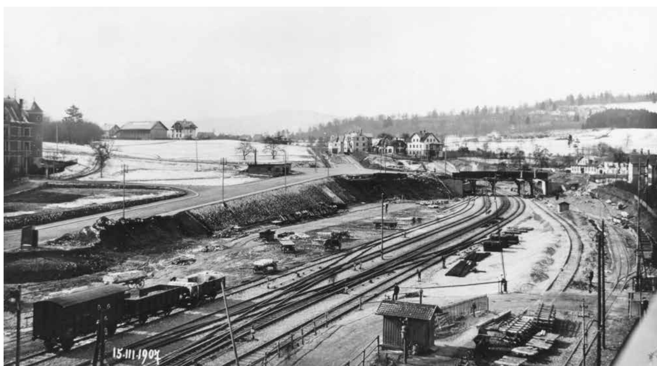
März 1907: Die Regensbergbrücke ist fertig gebaut; noch ist der westliche Brückenkopf aufzufüllen.
