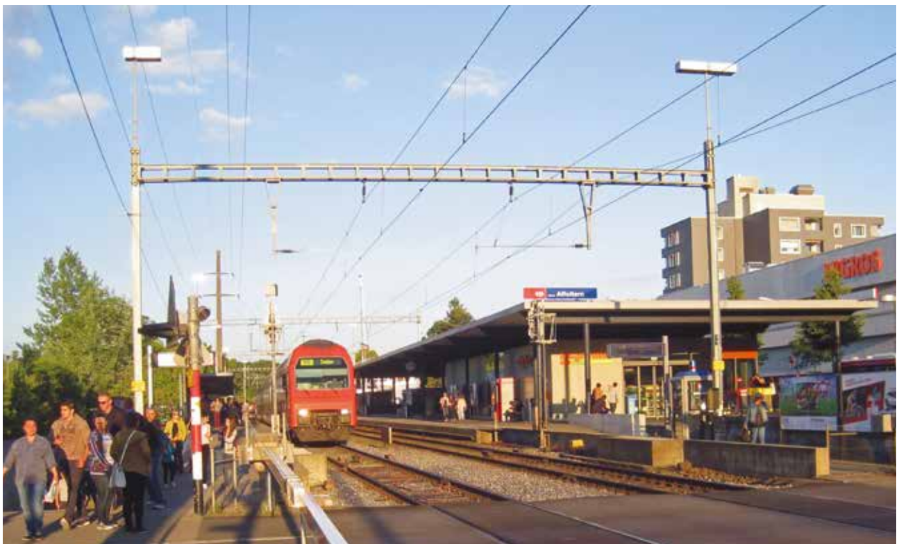
S-Bahn-Haltestelle Zürich Affoltern 2014: Soeben hat ein abendlicher Zug der S6 Richtung Baden Pendler gebracht. Rechts aussen wartet (stark verdeckt) der Anschlussbus der Linie 37 Richtung Waidhof. Das grosse Perrondach für die stadwärts fahrenden Züge ist im Jahr 2010 anstelle des ursprünglichen Dachs von 1997 erstellt worden.
