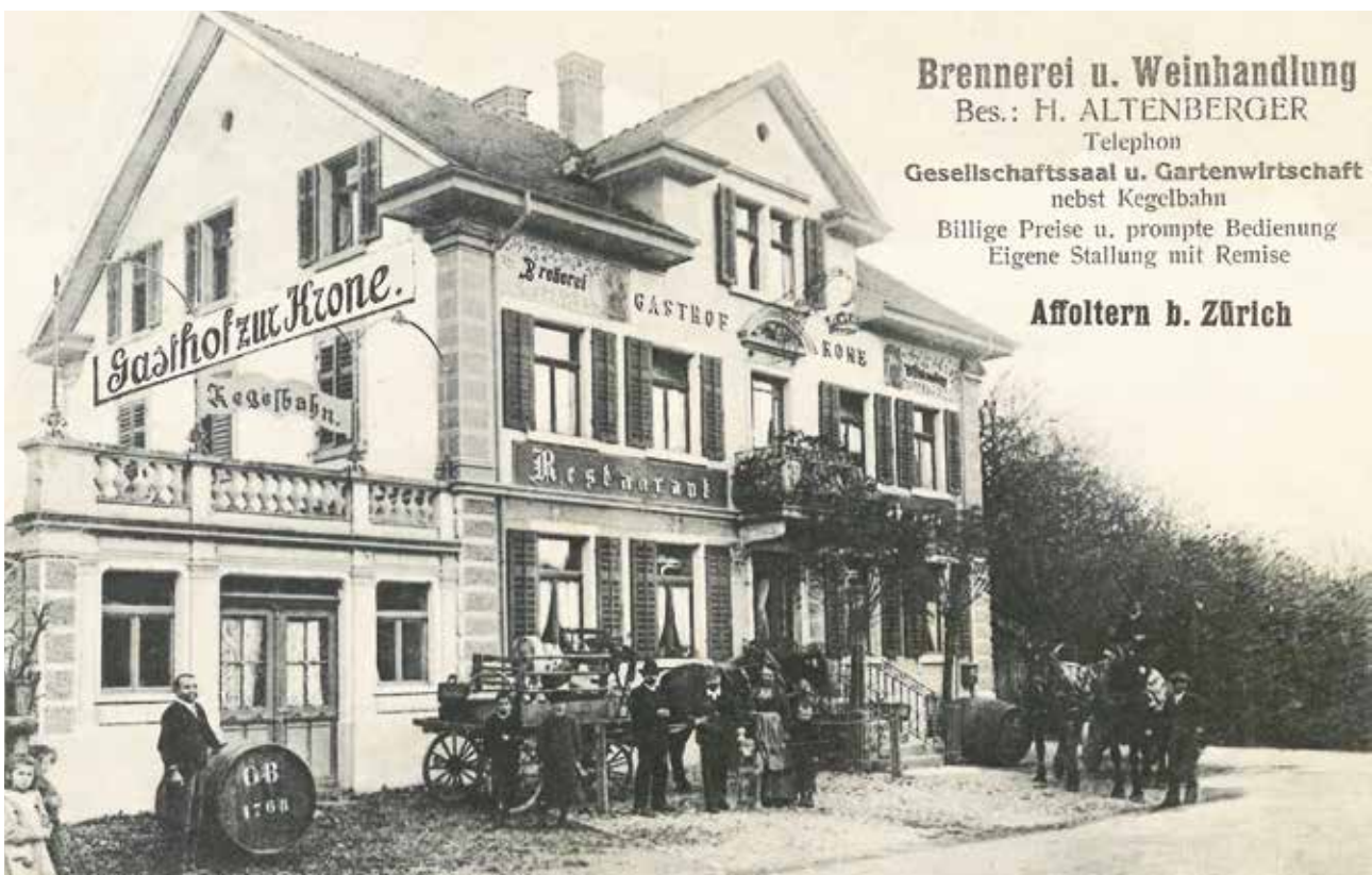
Das Restaurant Krone beim «Eingang». Als Heinrich Altenberger im Jahr 1922 starb, kaufte die Gemeinde Affoltern das Gebäude und machte daraus ihr Gemeindehaus. Nach der Eingemeindung von 1934 befand sich darin das Quartierbüro und später der örtliche Posten der Stadtpolizei. Quelle: QVA
