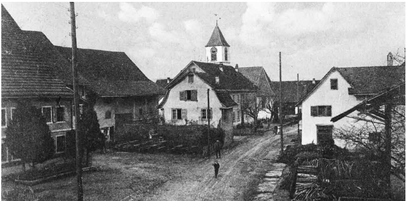
1910: Dorfstrasse bei der Kirche Regensdorf. Blick nach Norden; in der Bildmitte die Gartenwirtschaft des Restaurants Hirschen (links daneben), wo die Buslinie enden sollte.
