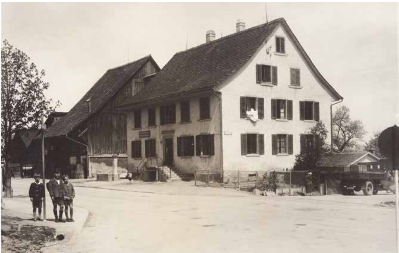
1929: Am Weg zum Milchbuck – der Fallende Brunnenhof dort, wo einige Jahre später die Wehntalerstrasse die Hofwiesenstrasse kreuzte.
