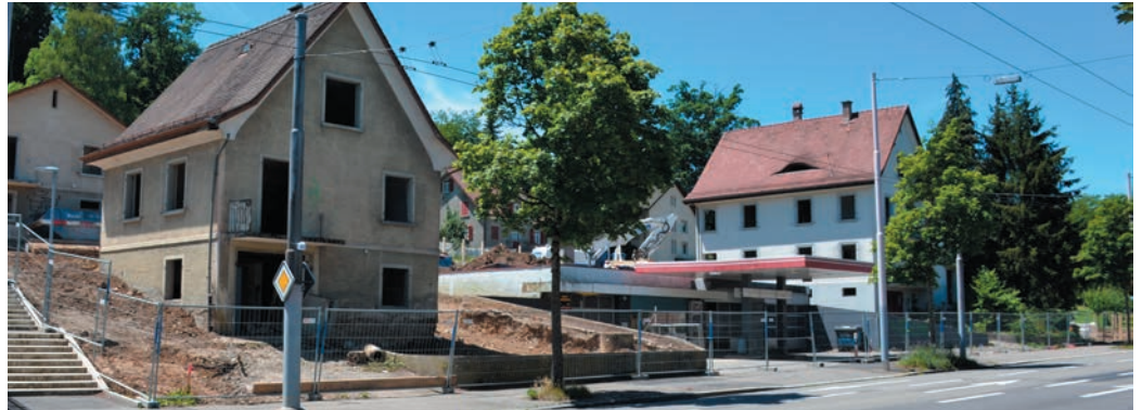
An der Obsthalde sind die Bagger aufgefahren.
